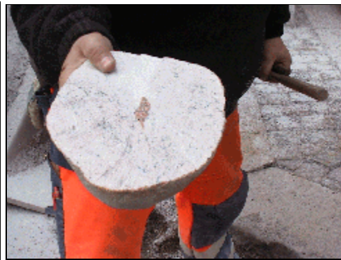
Bild: Gatuarbetare som klyver sten i två delar inför gjutning i vacuumform-maskin.
