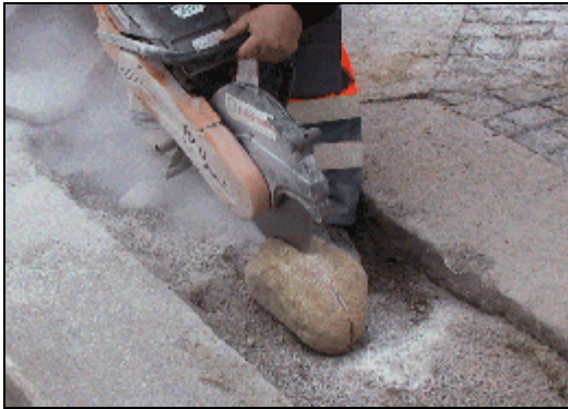
Bild: Gatuarbetare som klyver sten i två delar inför gjutning i vacuumform-maskin.
